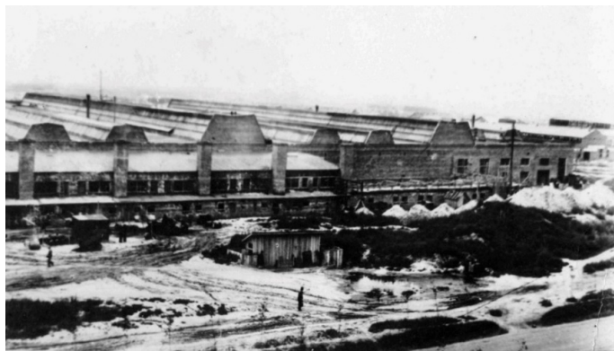
Строительство производственных корпусов, зима 1942, Трансмаш
