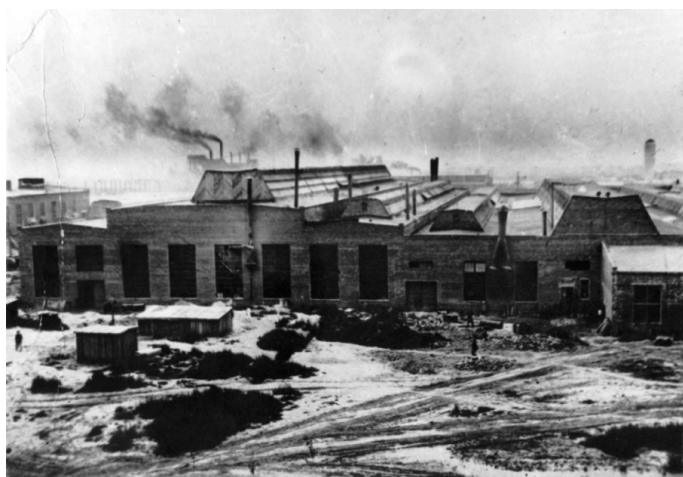
Строительство главного корпуса завода. Зима 1942 г. – 1943 вёл трест «Стройгаз»
